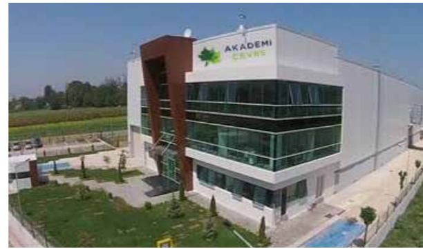
Kocaeli ATY Tesisi
