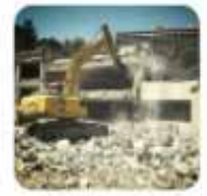
Kentsel Dönüşüm Bina Söküm Hizmeti
