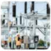
PCB - PCT Arındırma Hizmeti
